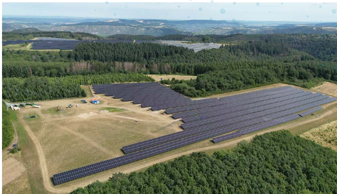
Solarpark Leiwien: Die zweite Teilfläche des Solarparks wurde Anfang 2024 in Betrieb genommen
