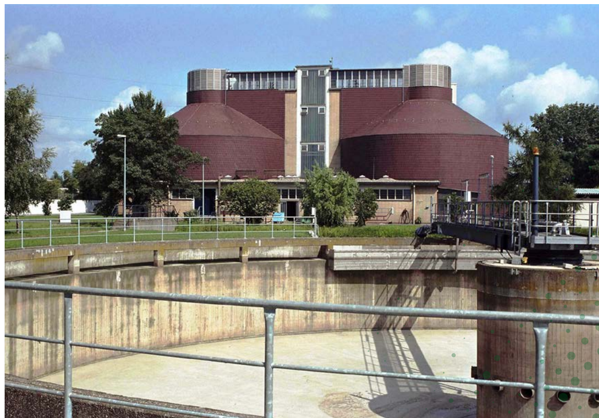
In den beiden Faultürmen wird der erneuerbare Energieträger Klärgas gewonnen
