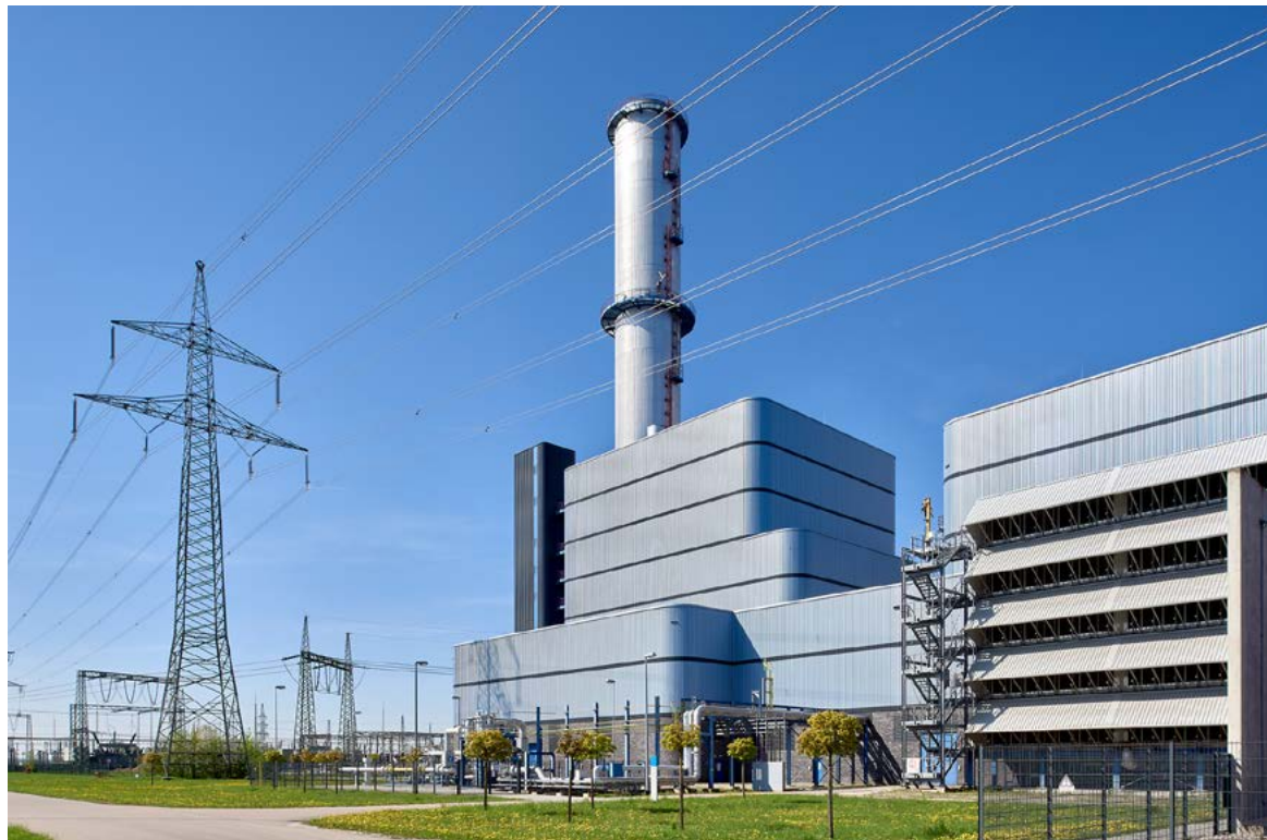
Das Gemeinschaftskraftwerk Irsching 5
