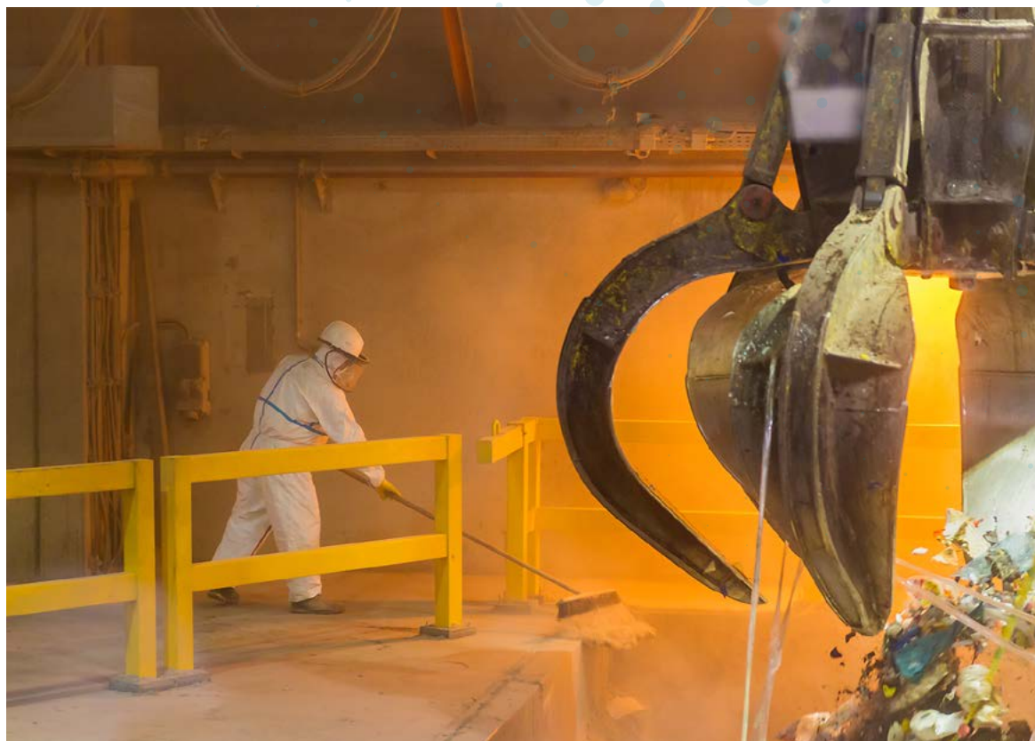
Die Abwärme aus der Müllverbrennung spielt eine immer größere Rolle in der Wärmeversorgung
