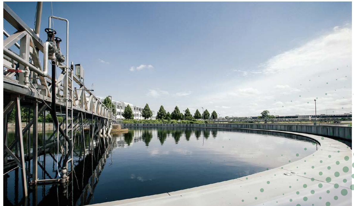
Das Darmstädter Zentralklärwerk
