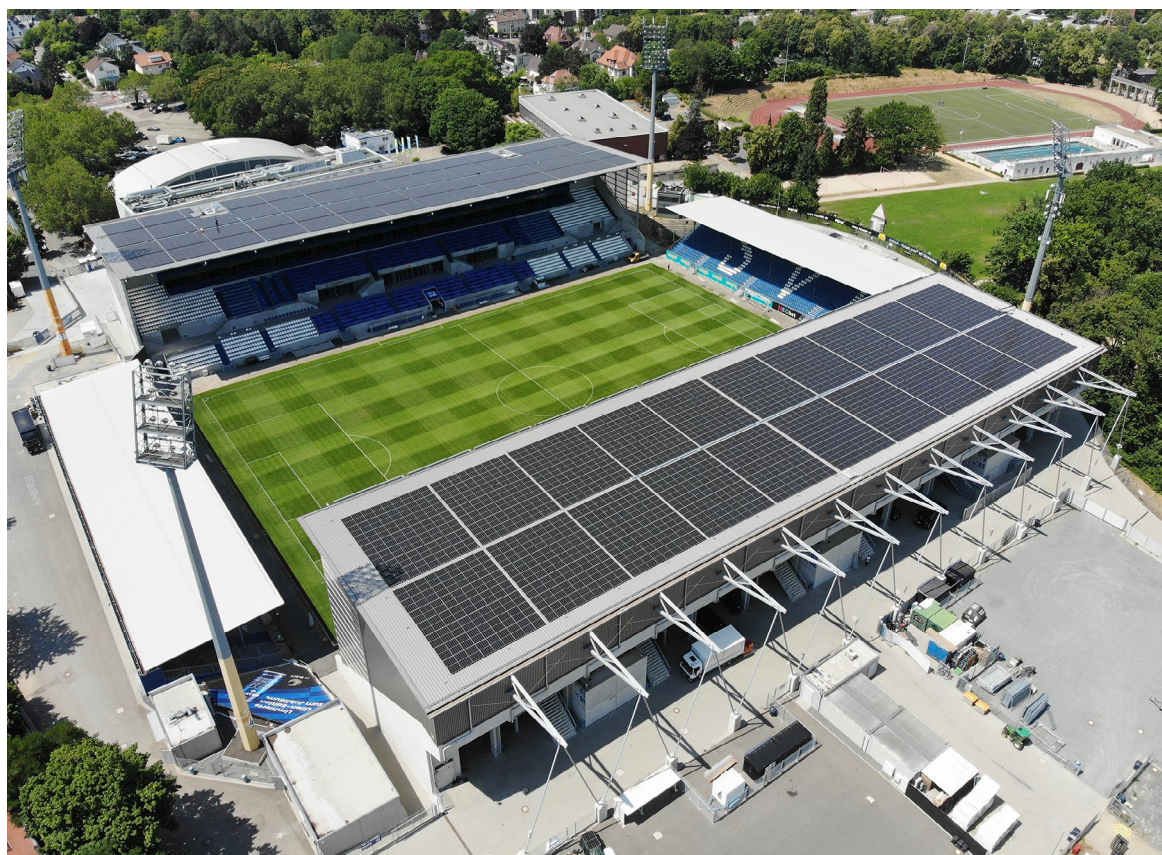
Die neue PV-Anlage auf dem Stadion der Lilien
