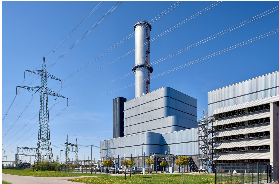
Das Gemeinschaftskraftwerk Irsching 5
