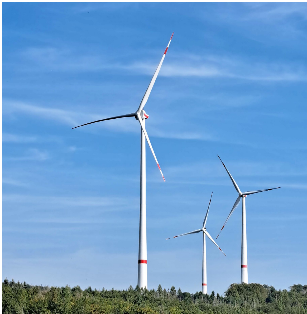
Der bestehende Windpark Haiger wurde im Berichtsjahr um eine Anlage (im Vordergrund) erweitert
