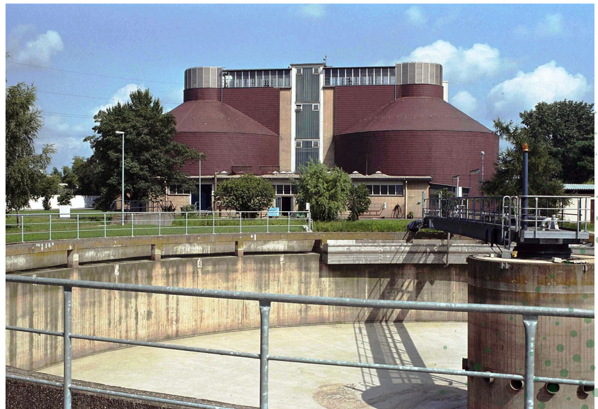
In den beiden Faultürmen wird der erneuerbare Energieträger Klärgas gewonnen
