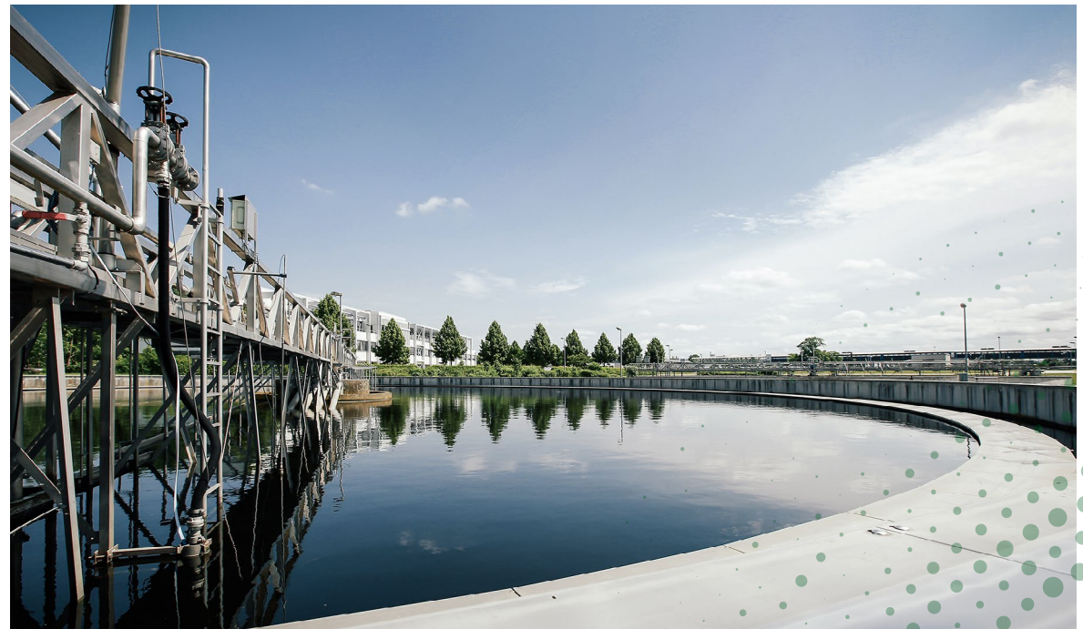
Das Darmstädter Zentralklärwerk
