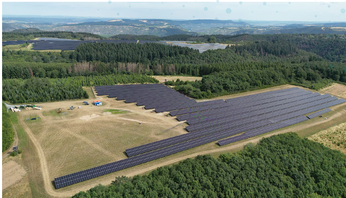
Solarpark Leiwien: Die zweite Teilfläche des Solarparks wurde Anfang 2024 in Betrieb genommen
